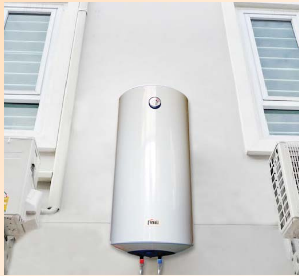
การติดตั้งภายนอก
